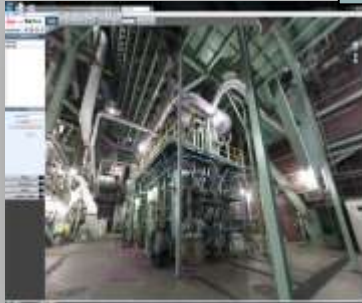
Plant 현황 파악
